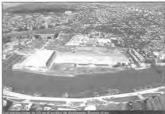
Las instalaciones de LPI en el barrio de Avellaneda, Buenos Aires
