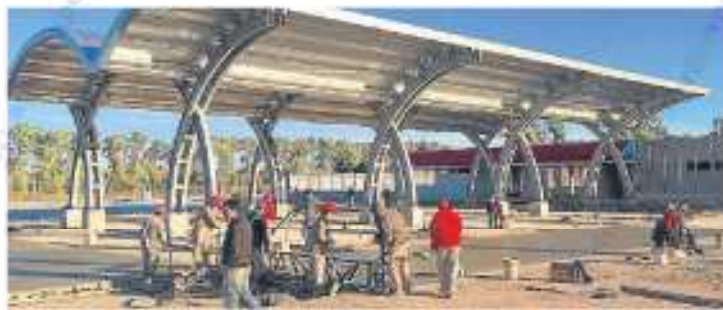
Luego de las demoras estivales, la construcción se acelera
