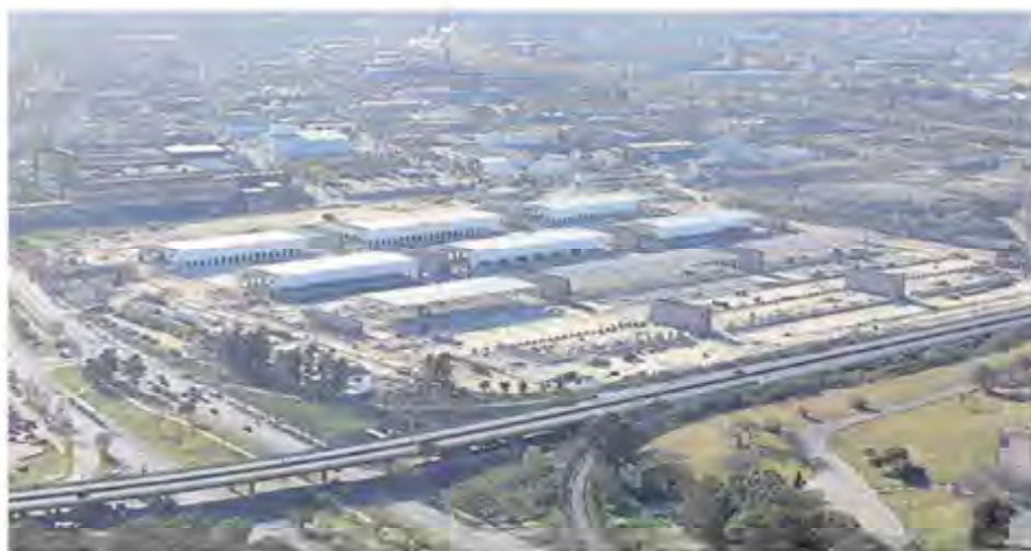
La toma aérea permite ver el estado de las obras
