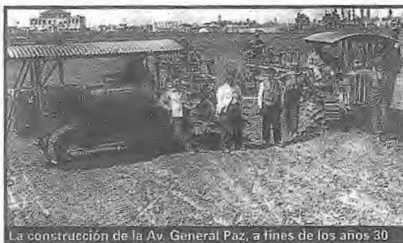
La construcción de la Av. General Paz, a fines de los años 30
