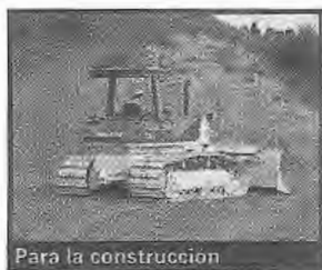
Para la construcción
