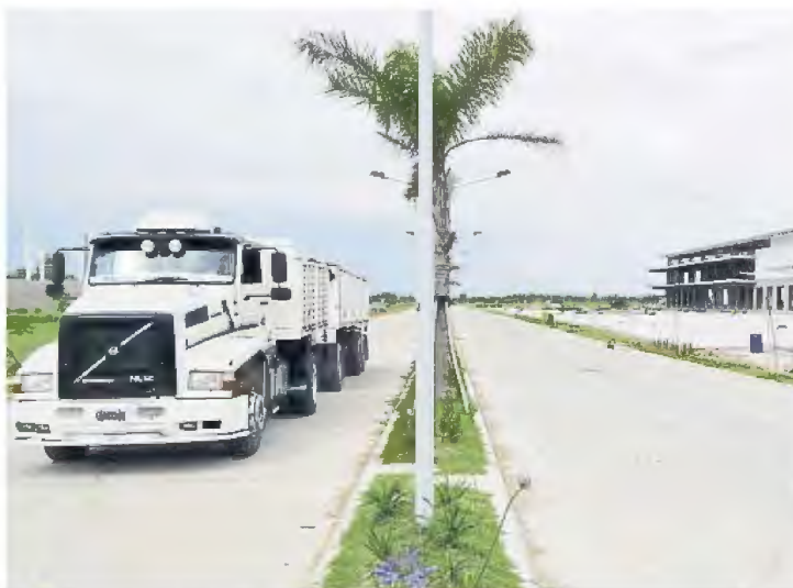
La calle central del proyecto inmobiliario logístico
